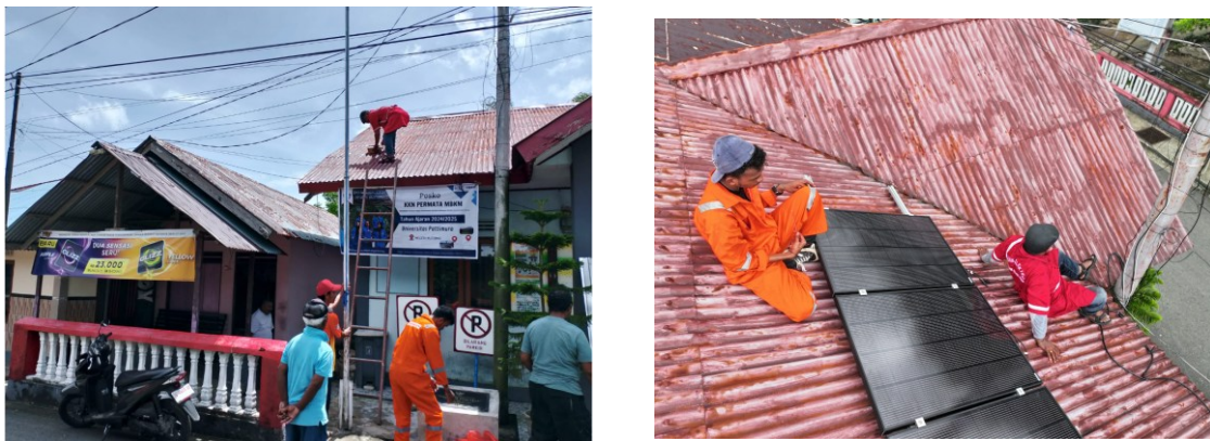
Gambar 3. Tahapan pemasangan panel surya di atap kantor
